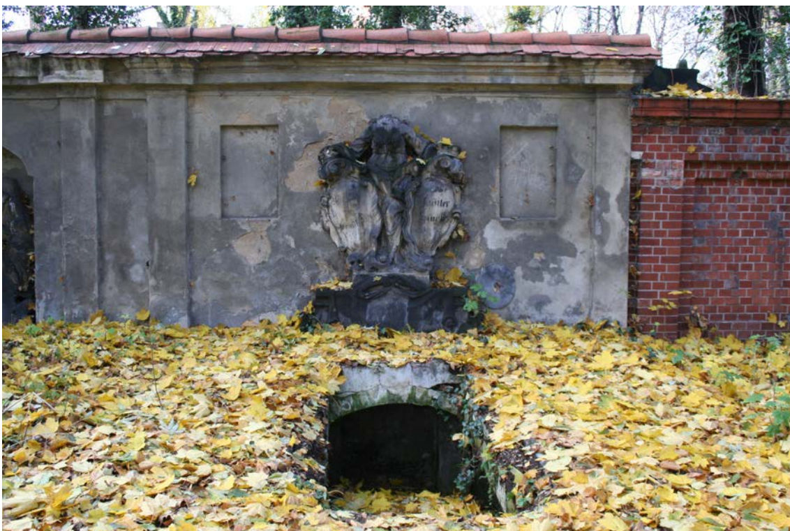
FOT.21. MUR WEWNĘTRZNY ZACH., ODCINEK F2, POMNIK W-10.
