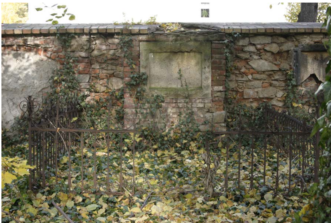
FOT.36. MUR PÓLNOCNY, ODCINEK B1, POMNIK N-1.
