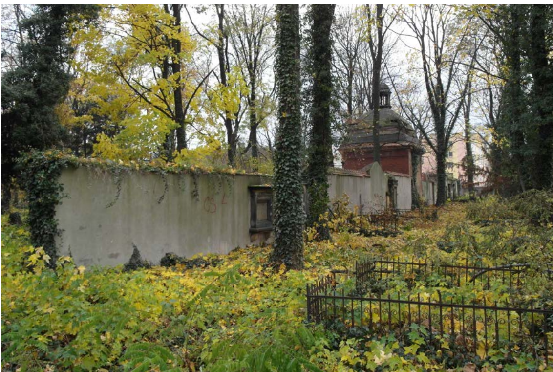
FOT.23. MUR WEWNĘTRZNY ZACH., ELEWACJA ZACH.WIDOK W KIERUNKU PŁD.
