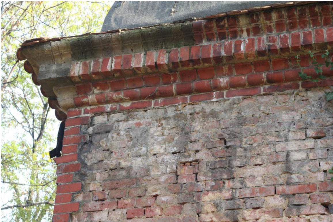
FOT.15. KAPLICA III, GZYMS KORONUJĄCY.
