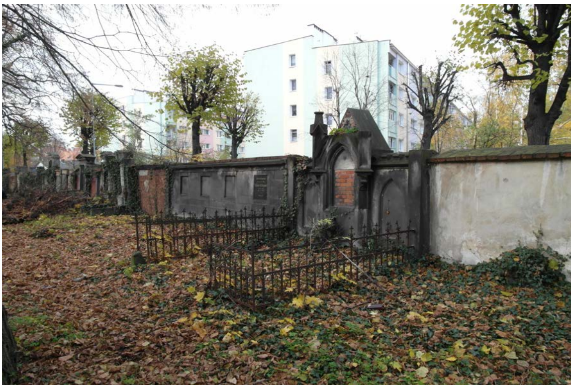
FOT.45. MUR PÓLNOCNY, ODCINEK D1.
