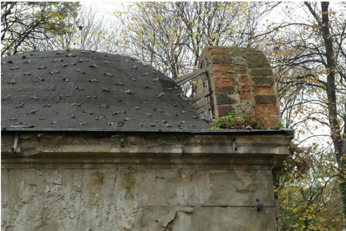
FOT.4. KAPLICA I, POKRYCIE DACHU I SZCZYT.
