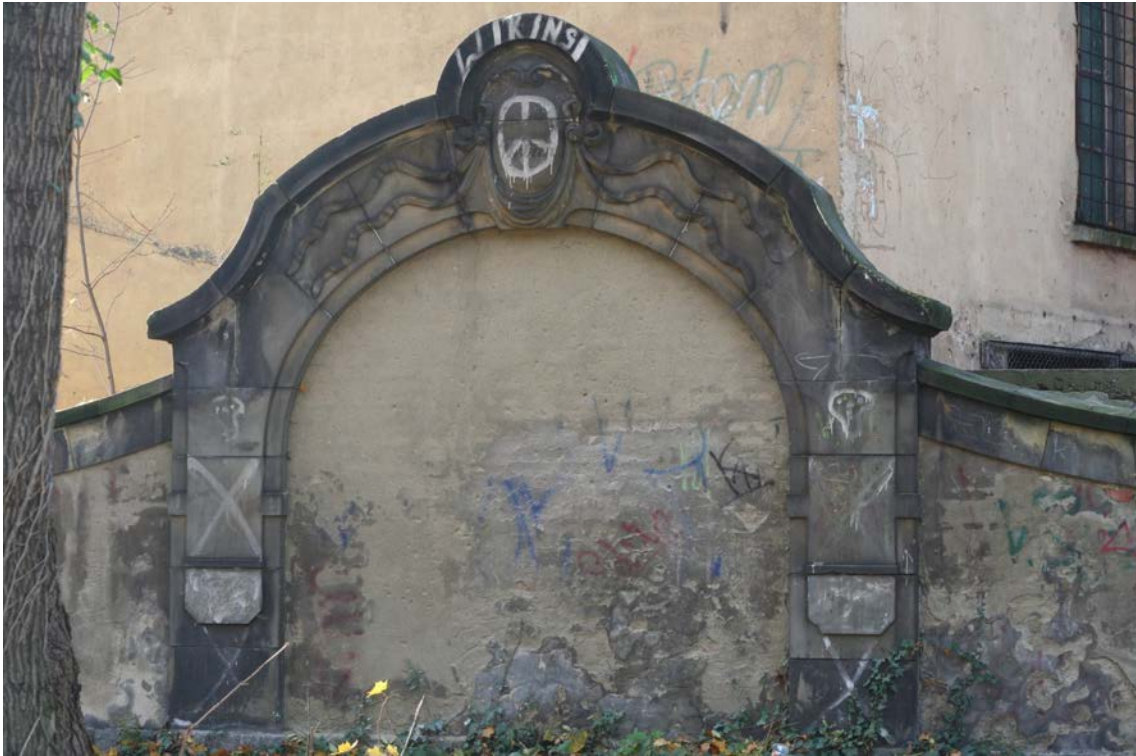
FOT.33. ZEWNĘTRZNY MUR ZACH., ODCINEK G., CENTRALNA PARTIA POMNIKA NAGROBNEGO.
