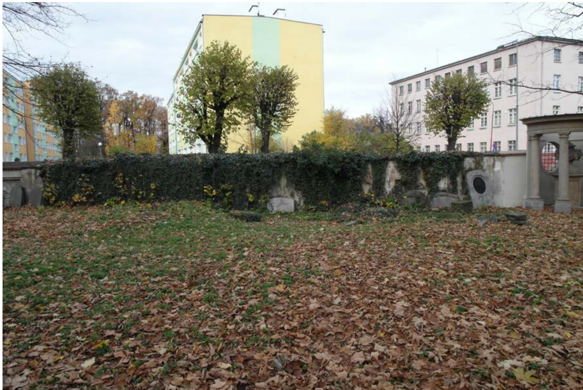
FOT.51. MUR PÓŁNOCNY, ODCINEK F1.
