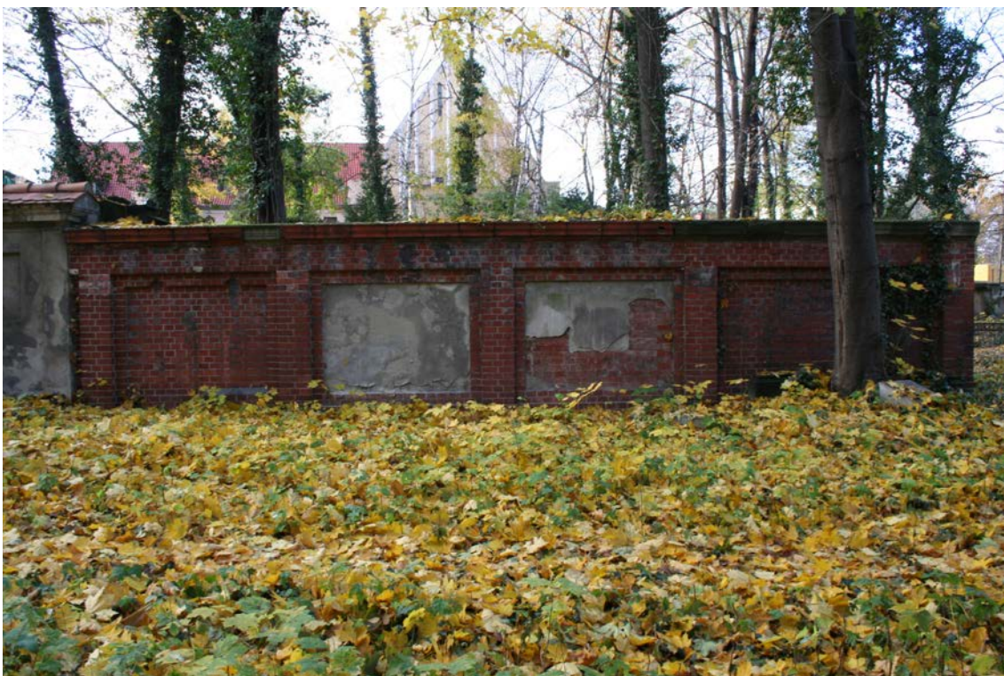
FOT.22. MUR WEWNĘTRZNY ZACH., ODCINEK G (W-11).
