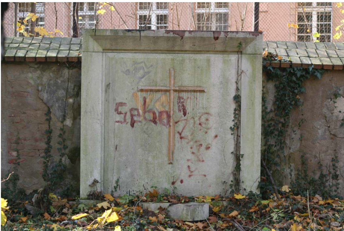
FOT.32. ZEWNĘTRZNY MUR ZACH., ODCINEK F., TABLICA NAGROBNA.
