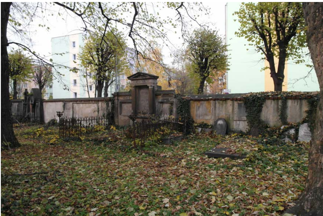
FOT.47. MUR PÓLNOCNY, ODCINEK D2.
