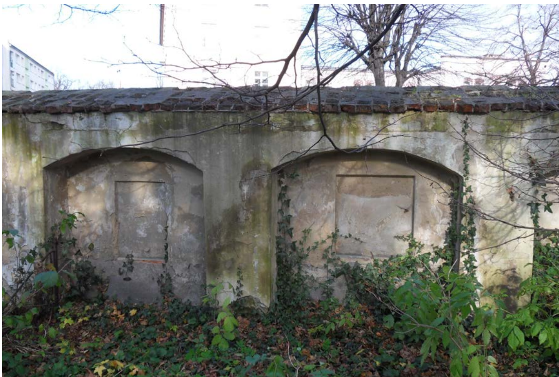
FOT.53. MUR PÓŁNOCNY, ODCINEK G1, ARKADY W MURZE WYPEŁNIONE BLENDAМИ.
