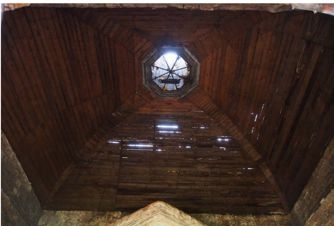
FOT.18. KAPLICA III, POZORNA KOPUŁA.
