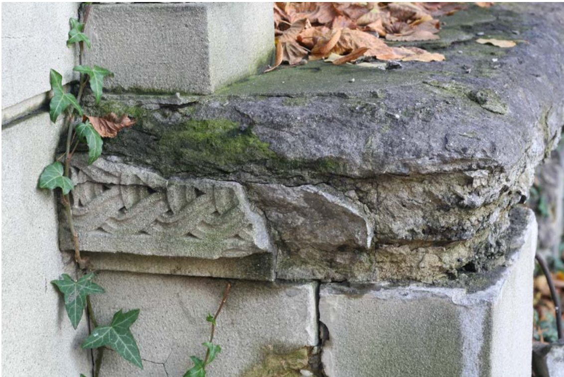
FOT.41. MUR PÓŁNOCNY, ODCINEK C2, POMNIK N-10, SKORODOWANY FRAGMENT.
