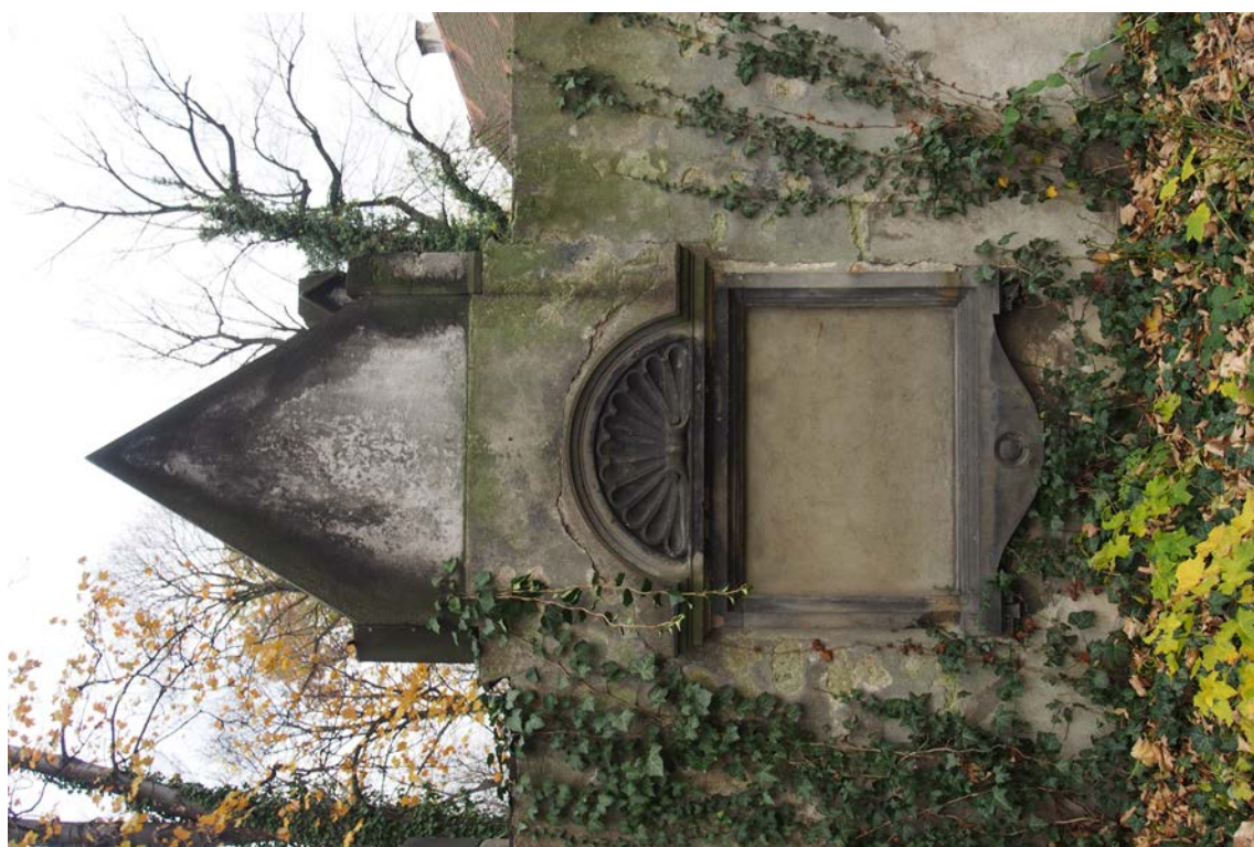
FOT.28. MUR WEWNĘTRZNY ZACH., ELEWACJA ZACH., ODCINAK K, OBRAMIENIE PŁYTY EPITAFIJNEJ W-17.
