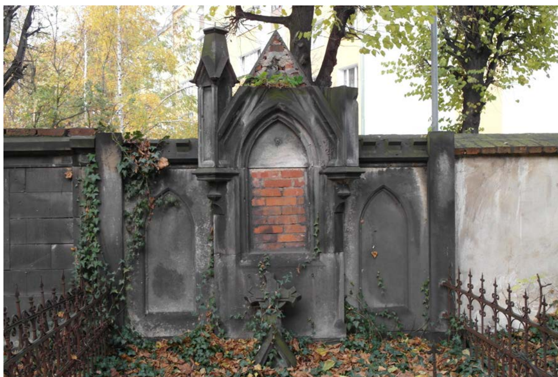
FOT.46. MUR PÓLNOCNY, ODCINEK D1, POMNIK N-17.
