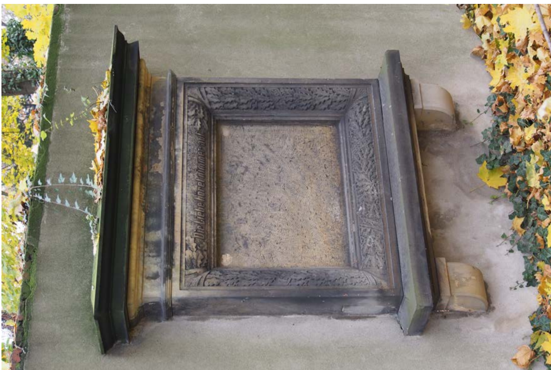
FOT.25. MUR WEWNĘTRZNY ZACH., ODCINEK H, PŁYTA EPITAFIJNA W-12.
