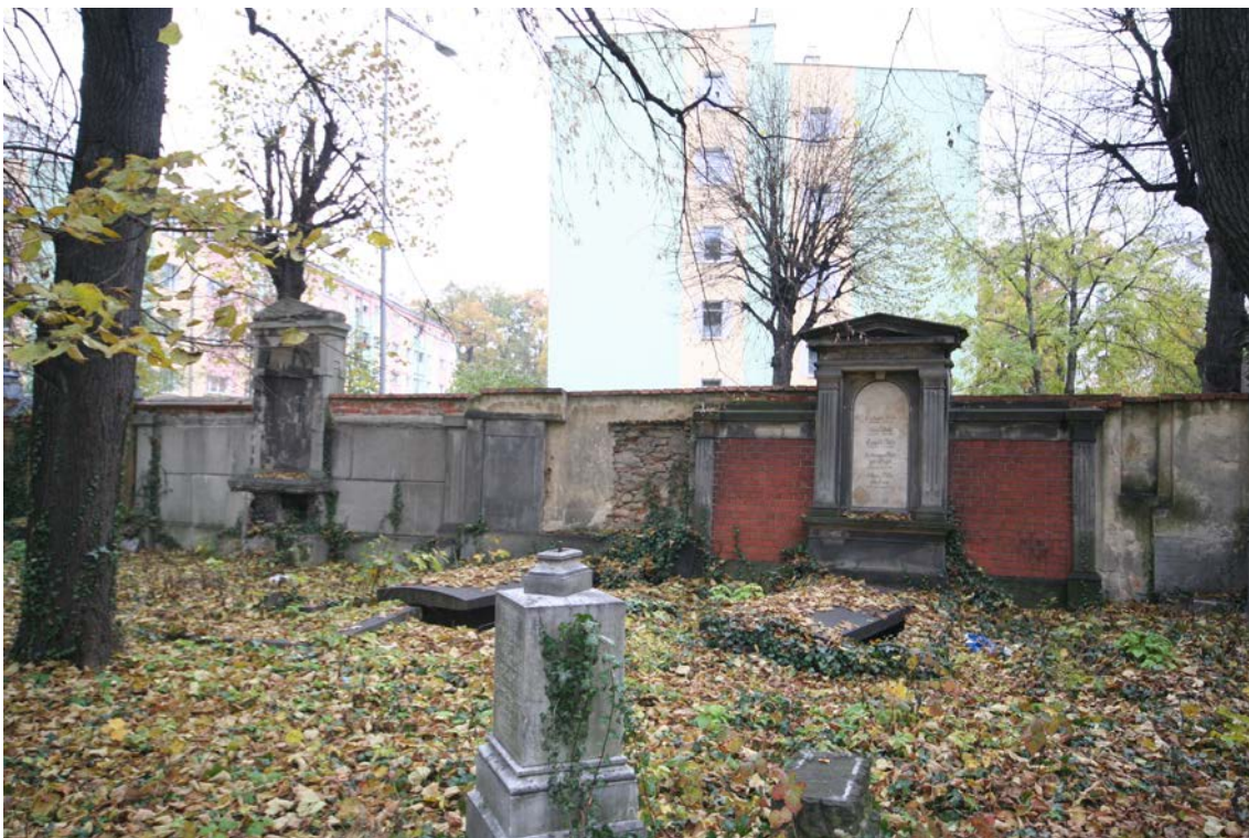
FOT.39. MUR PÓŁNOCNY, ODCINEK C2.
