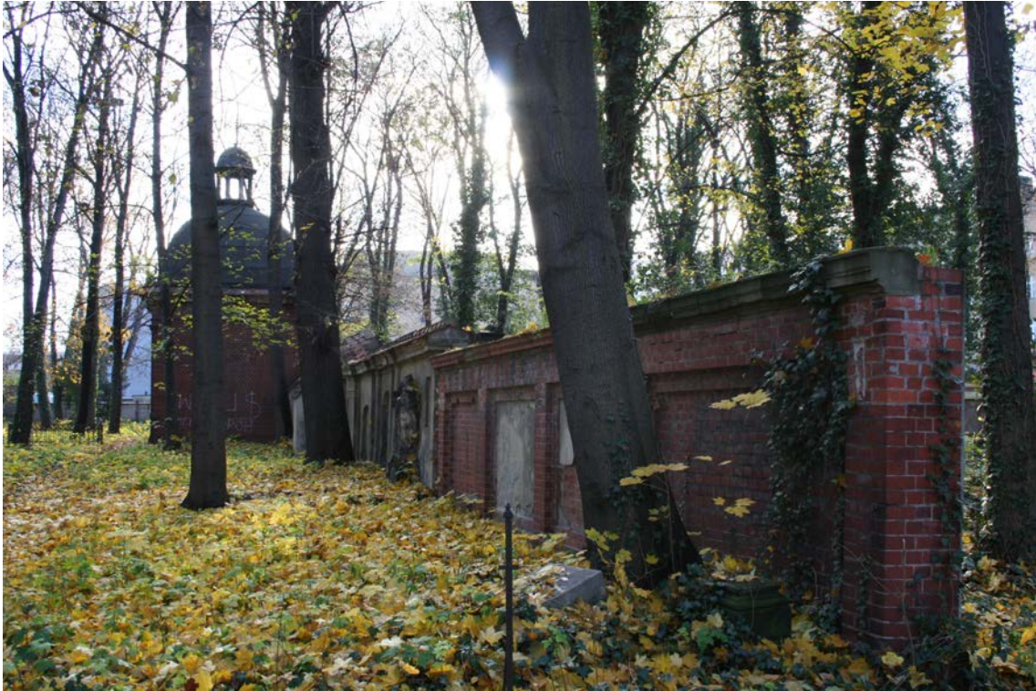
FOT.9. WEWNĘTRZNY MUR ZACHODNI, ELEWACJA WSCH., WIDOK W KIERUNKU PŁD.
