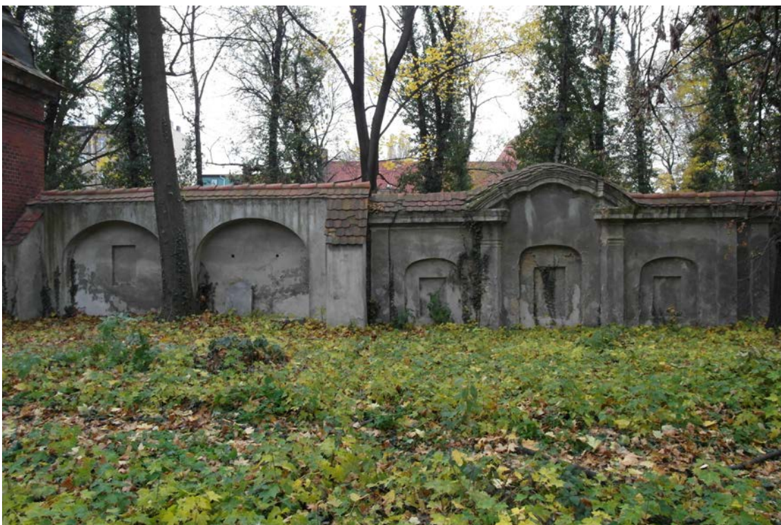
FOT.19. MUR WEWNĘTRZNY ZACH., ODCINEK F1 I F2, (W-7 ORAZ W-8).
