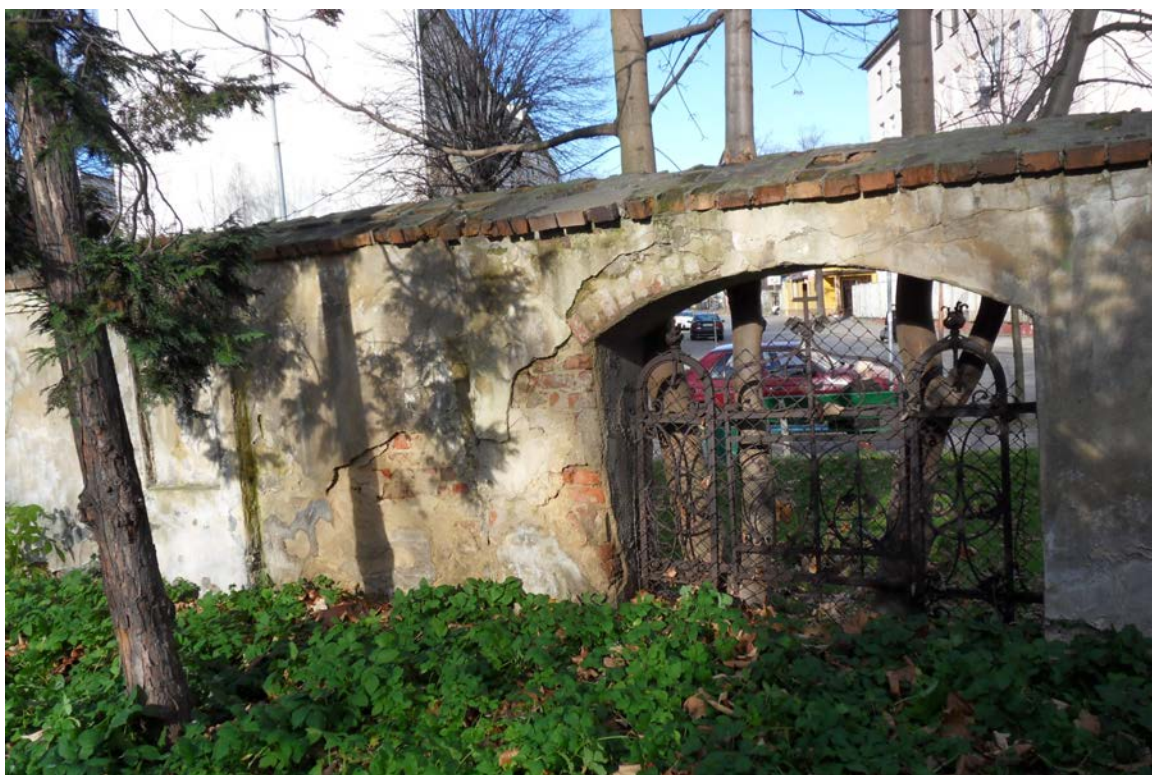
FOT.52. MUR PÓŁNOCNY, ODCINEK F2, PRZEPRUCIE W MURZE WYPEŁNIONE OZDOBNĄ KRATĄ.
