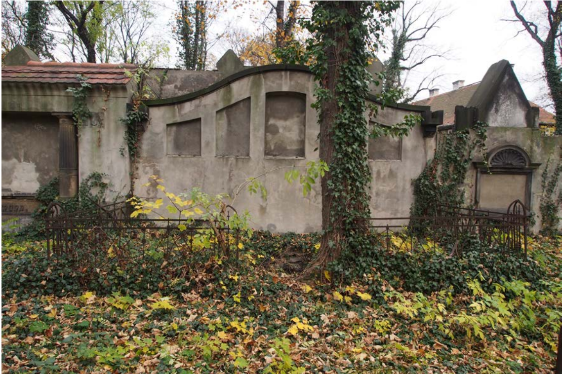
FOT.29. MUR WEWNĘTRZNY ZACH., ODCINEK J, POMNIK W-16.
