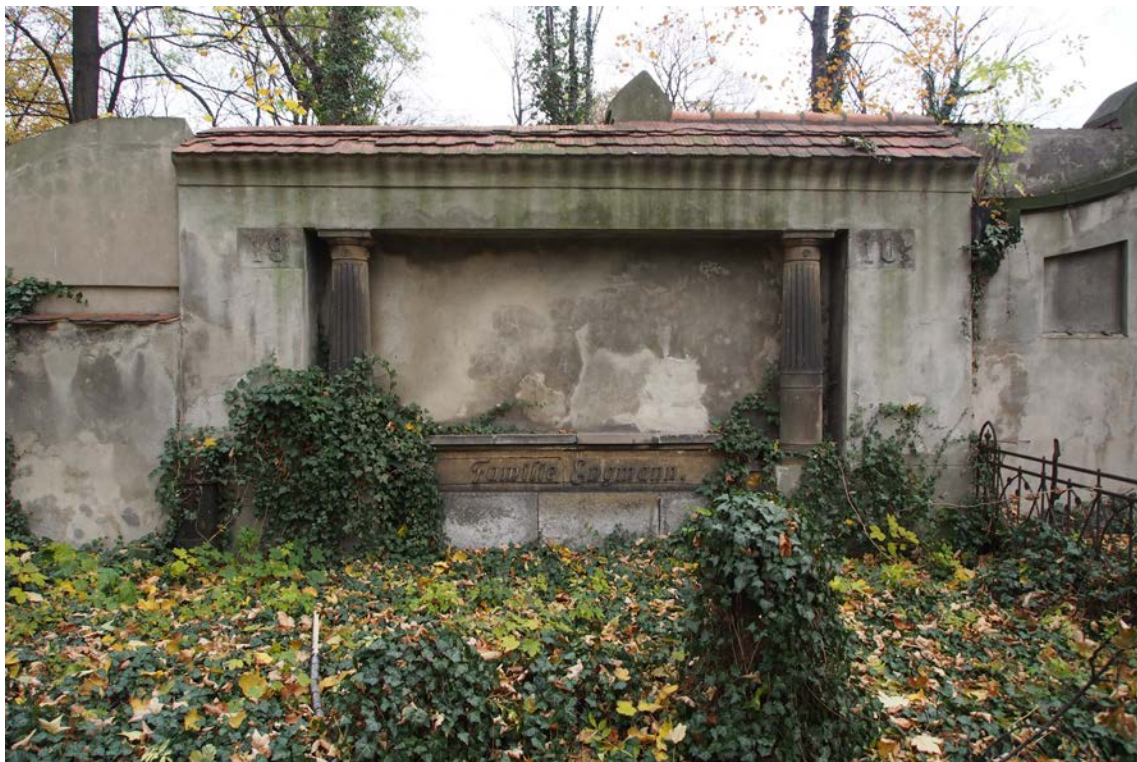
FOT.30. MUR WEWNĘTRZNY ZACH., ODCINEK J, POMNIK W-15.
