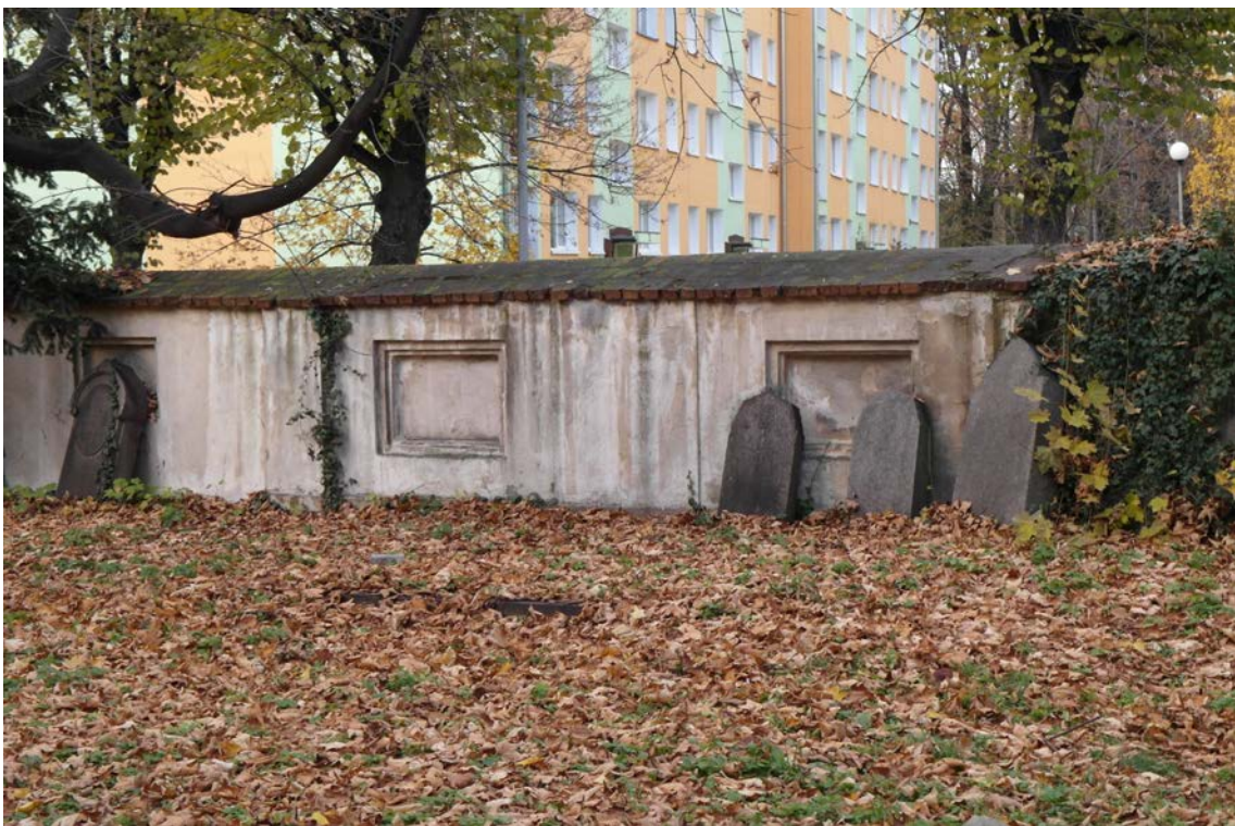
FOT.50. MUR PÓLNOCNY, ODCINEK E2.
