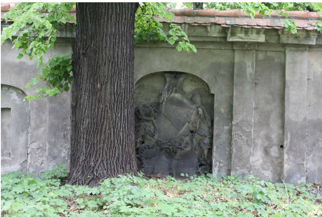
FOT.20. MUR WEWNĘTRZNY ZACH., ODCINEK F2, POMNIK W-9.
