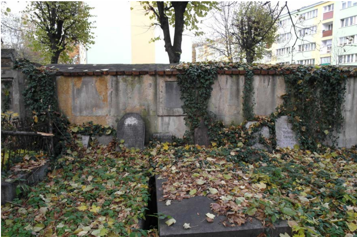
FOT.49. MUR PÓLNOCNY, ODCINEK D2, N-19.
