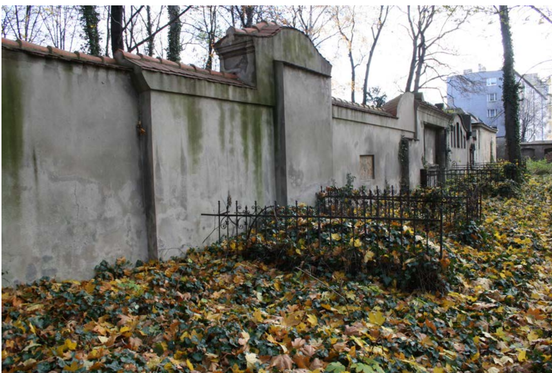
FOT.24. MUR WEWNĘTRZNY ZACH., ELEWACJA ZACH.
