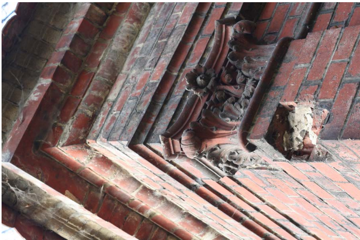
FOT.16. KAPLICA III, CERAMICZNY DETAL ARCHITEKTONICZNY.
