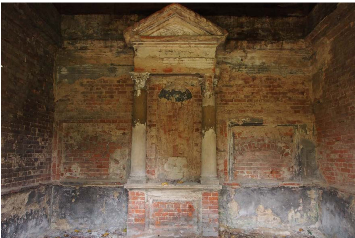
FOT.17. KAPLICA III, WNĘTRZE, ZACHOWANE RELIKTY WYSTROJU.
