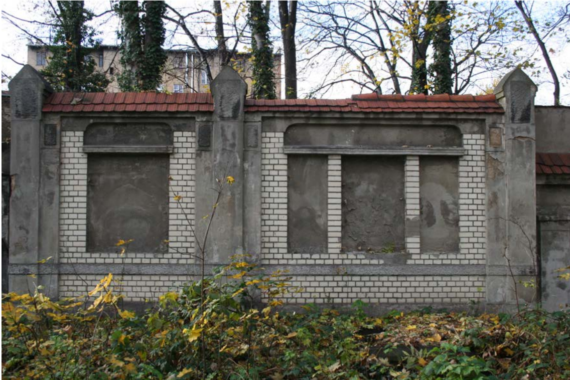
FOT.11. WEWNĘTRZNY MUR ZACH., ELEWACJA WSCH., ODCINEK C2, KLINKIEROWA LICÓWKA MURU (W-3).
