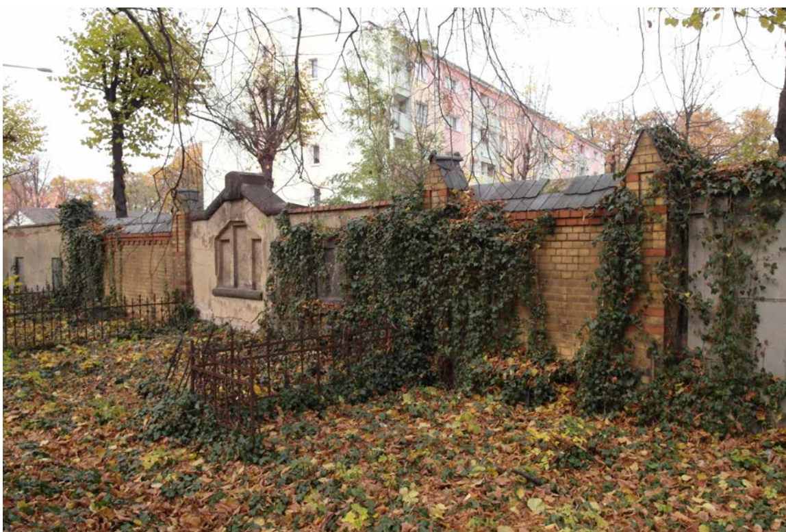
FOT.38. MUR PÓŁNOCNY, ODCINEK C1.
