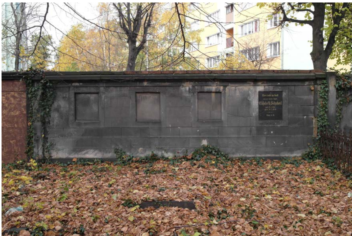
FOT.44. MUR PÓŁNOCNY, ODCINEK D1, POMNIK N-16.
