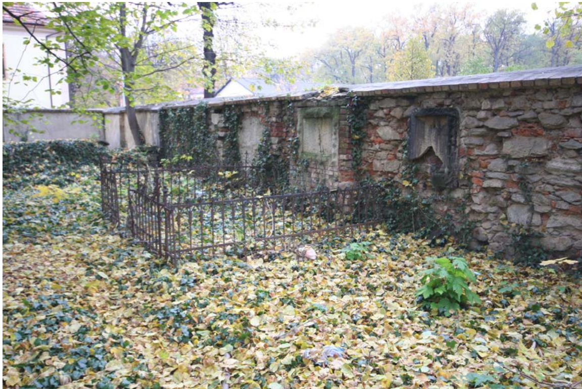
FOT.35. MUR PÓLNOCNY, ODCINEK B1.
